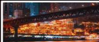
สะพานฉางผู่
