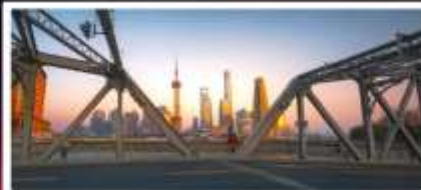
สะพานวอไปตู้
