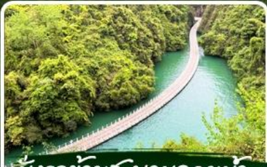
นั่งรถข้ามสะพานลอยน้ำ
